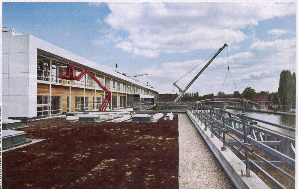
La passerelle posée sur le canal de l'Ourcq à la mi-avril profitera aussi aux habitants des Pavillons-sous-Bois.
