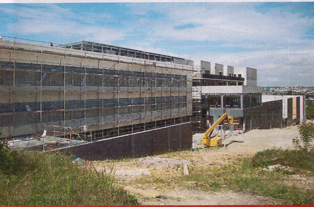
Le bâtiment se déploie sur 163 m, en trois terrasses, sur une pente marquée par une forte déclivité (14 m).
